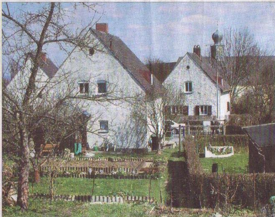
Blick in die Ganghofer-Siedlung: Die Häuschen sind hübsch, aber sanierungsbedürftig.
