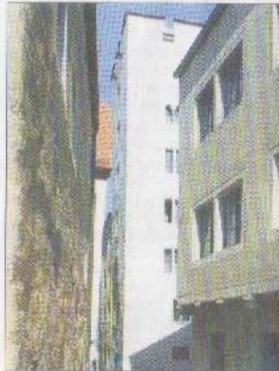
Turmwohnung des Stadtbau-Aufsichtsrats Kurt Schindler Foto: altrofoto.de
